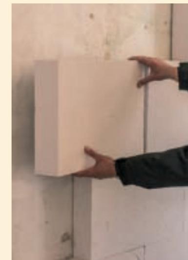
Innendämmsystem mit mineralischer Dämmplatte.
